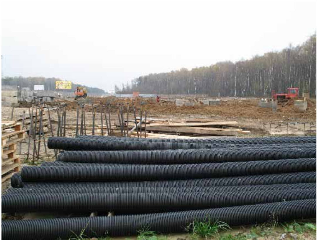
Рисунок 1.3 – Общий вид пластмассовых профилированных труб ПЕРФОКОР
