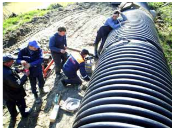
Рисунок 1.2 – Общий вид пластмассовых профилированных труб КОРСИС ПЛЮС
