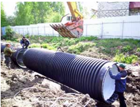
Рисунок 1.2 – Общий вид пластмассовых профилированных труб КОРСИС ПЛЮС
